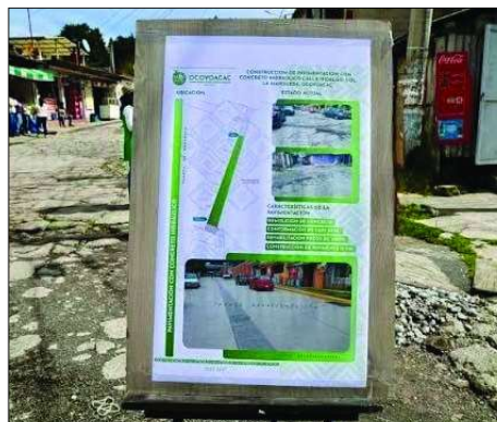
CALLE EVERARDO GONZÁLEZ, SANTA MARÍA HUEXOCULCO, CHALCO Obra del programa Caminemos Seguras, con mejoramiento de vialidad e infraestructura peatonal.
