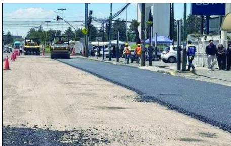
AVENIDA INDUSTRIA AUTOMOTRIZ, ZONA INDUSTRIAL DE TOLUCA Rehabilitación vial dentro del corredor industrial de la capital mexiquense.
